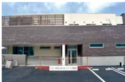
新たに誕生した管理棟の外観
